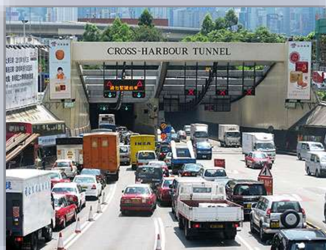
红磡海底隧道
