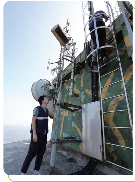
通訊辦職員正檢查安裝在通訊塔上器材的狀況。
