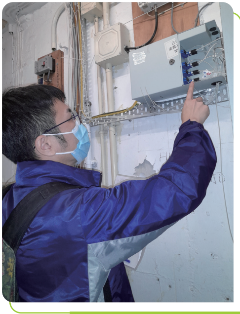
通訊辦職員巡查光纖到樓／光纖到戶設備。
