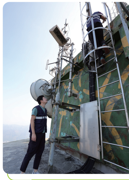
通訊辦職員正檢查安裝在通訊塔上器材的狀況。
